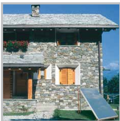
Пример наземного монтажа
