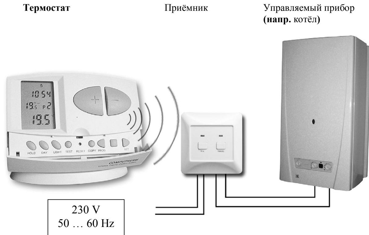
Термостат состоит из двух частей – свободно переносимого комнатного термостата и принимающего устройства, которое осуществляет управление котлом /конденционером. Между двумя устройствами существует радиочастотная связь и нет необходимости в осуществлении проводной связи между термостатом и котлом /конденционером. На заводе оба устройства настроены на одну частоту для совместной коммуникации.
