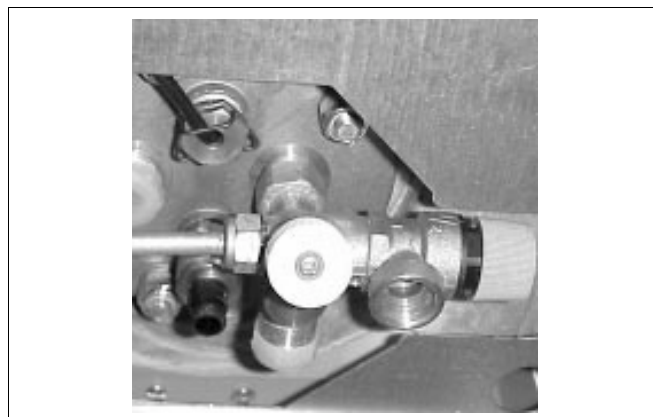
Рис. 39 Кран для заполнения
